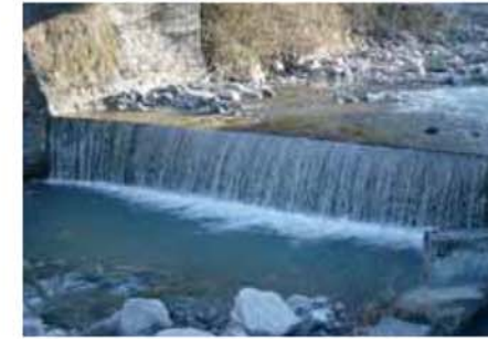
Solche Querverbauungen sind für praktisch alle Fische und Wasserkleintiere überwindbare Barrieren. Die freie Wanderung ist unterbrochen.
